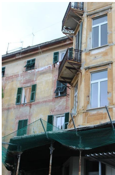
Figura 1.1 - Vista della facciata esposta a sud-ovest
