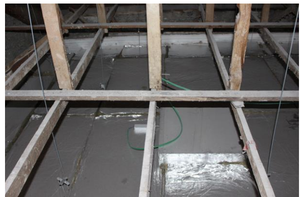
Figura 4.2 - Particolare coibentazione solaio sottotetto
