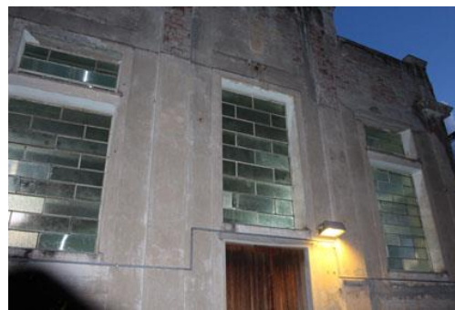
Figura 8.5 - Particolare serramento in metallo esistente
