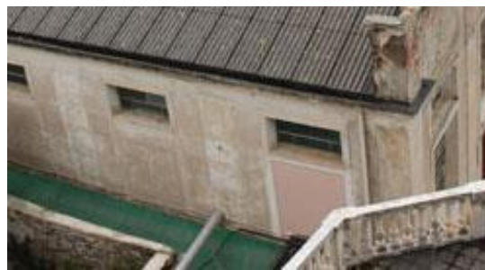
Figura 8.1 - Particolare di una facciata della palestra
