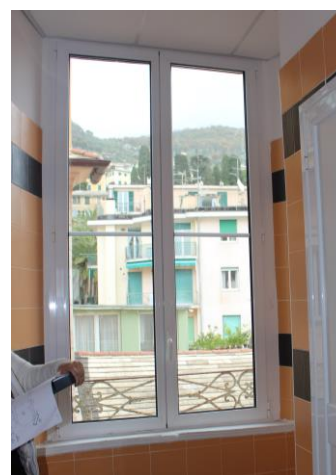
Figura 4.2 - Particolare dei serramenti sostituiti
